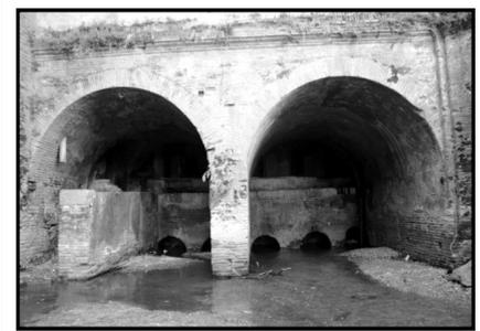
Arches à l'arrière du moulin pour l'évacuation des eaux. Sur le haut de la voûte se trouve la chambre à eau.
