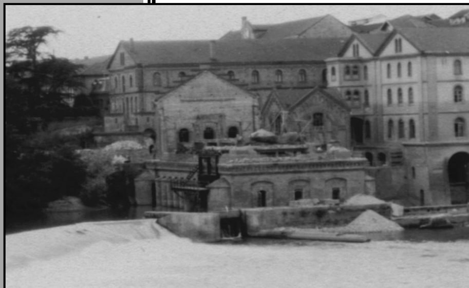
L'inondation du 3 mars 1930 cause la destruction de la centrale électrique, reconstruite à l'identique en 1930 (date inscrite sur la façade)
