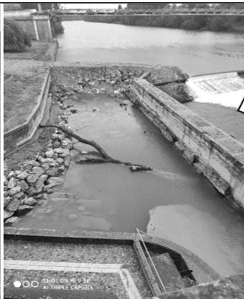
Construction d'un batardeau d'eau pour mettre en sécurité le bajoyer après la formation d'un renard hydraulique
