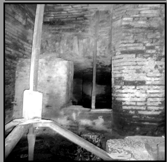
Arbre de liaison entre le rouet et la meule (Photo AVH)
