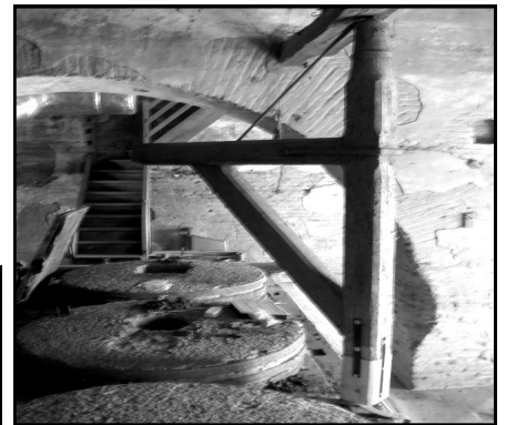
A droite, potence pour lever les meules (Photo AVH)
