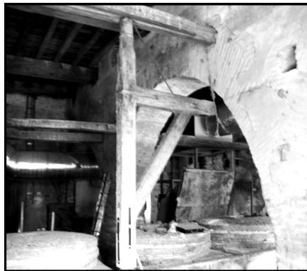
A gauche, la chambre des meules (Photo AVH)
