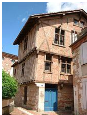
Agen : maison à colombage
