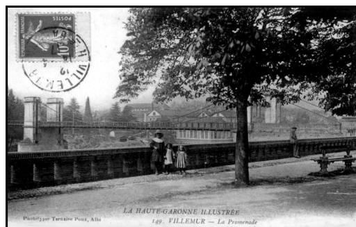
L'ancienne murette des allées et le pont suspendu (1902)
