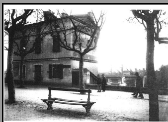
Maison éclusière rive droite
