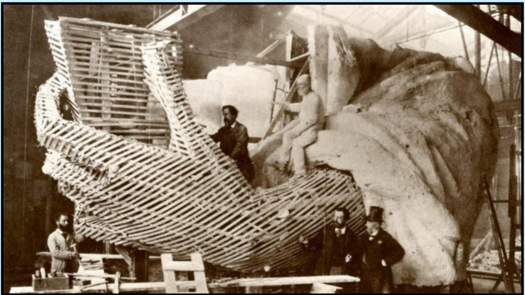
Sur cette image montrant la main en cours de fabrication, on observe la structure en bois à base de tasseaux servant au moulage en plâtre de la main de la statue.
